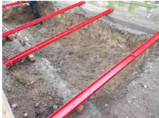
Die teilzerlegte Toilette wurde nach der Fertigstellung des neuen Fundamentes mit Stahlträgern wieder am alten Platz montiert.
